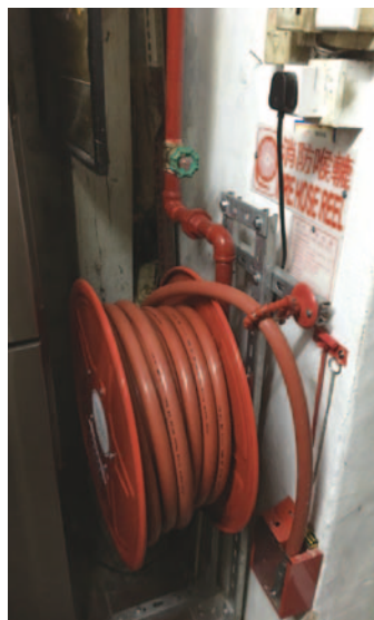
折衷式喉轆系統。 The Improved Hose Reel System.
